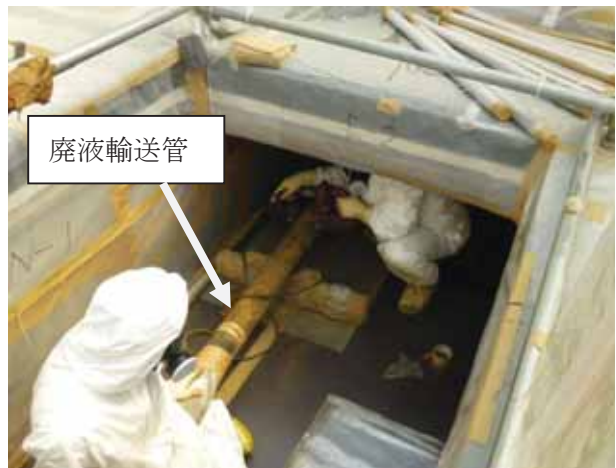
写真 2.3.2-2 廃液輸送管撤去作業状況
