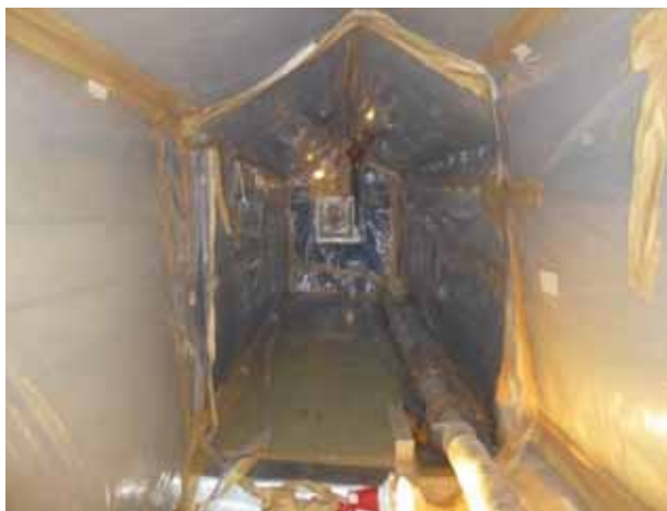
写真 2.3.2-1 廃液輸送管敷設状況
